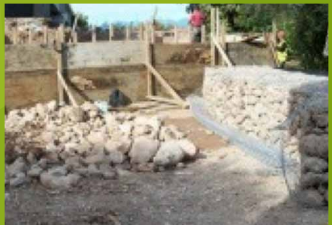
Ch 79+209-79+240, RW39 gabions construction
