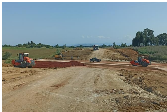
L810 (k.p. 39+700): Embankment
