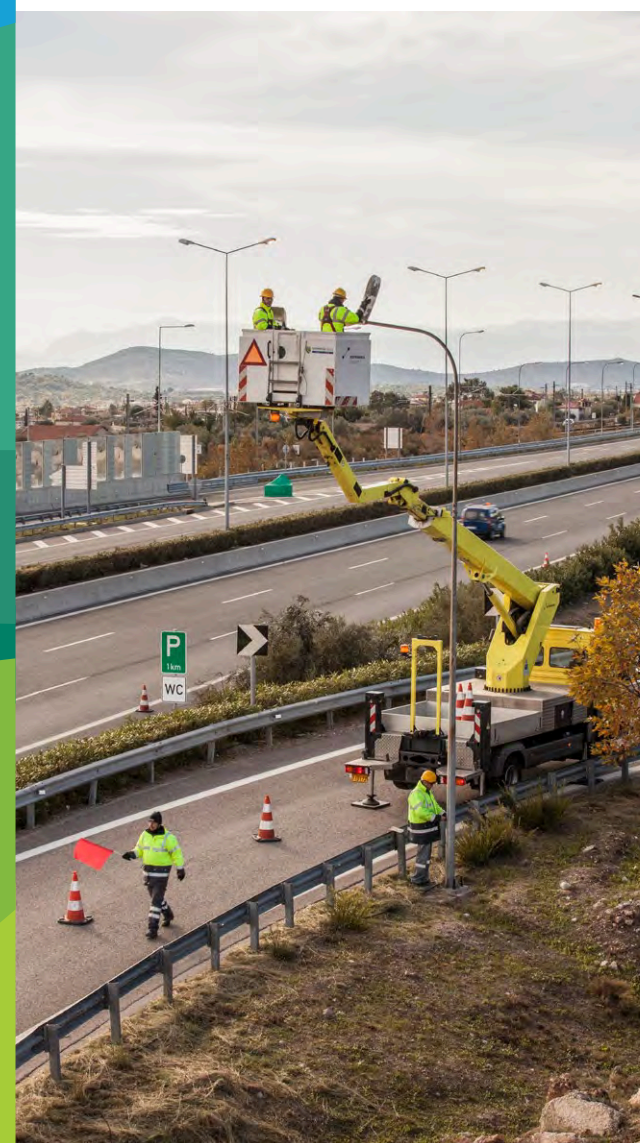
Εργασίες επιθεώρησης & συντήρησης σε καθημερινή βάση
