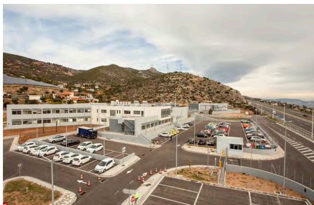
2 Κέντρα Εκμετάλλευσης & Συντήρησης σε Νέα Πέραμο & Ρίο και Τεχνικές Βάσεις σε Κιάτο και Ακράτα
