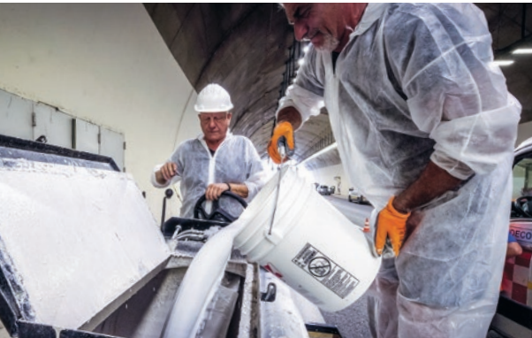
2. Ανάμειξη των συστατικών του υλικού επίστρωσης
