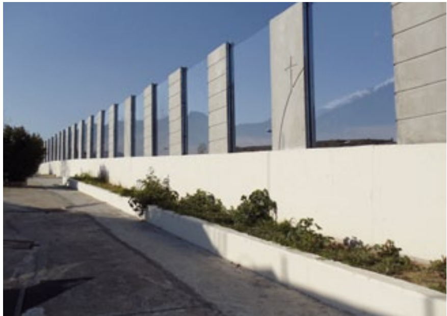
Εγκατάσταση αντιθορυβικών πετασμάτων, στα υφιστάμενα τμήματα του Έργου (l. Μονή Ζωοδόχου Πηγής, Ευρεία Παράκαμψη Πάτρας)
