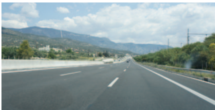
Άποψη από το τμήμα Ελευσίνα-Κόρινθος
