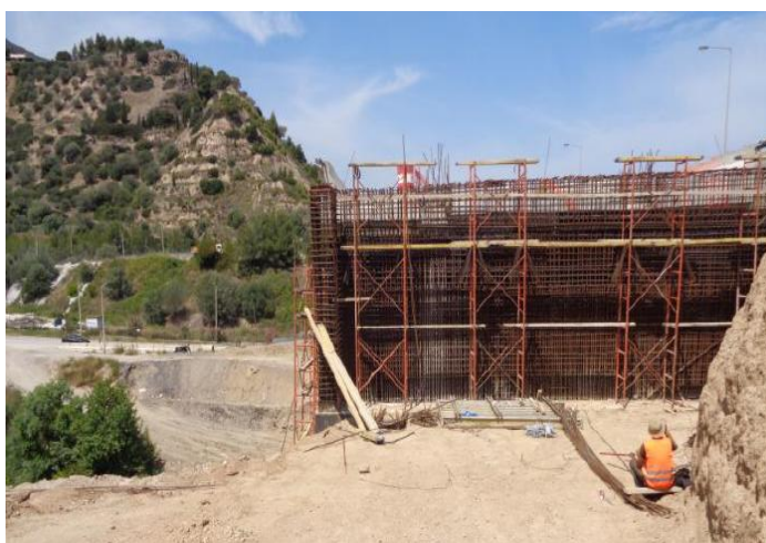
B269 – Κατασκευή οπισθίου τοιχίου
