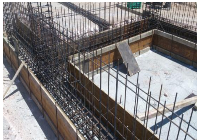
Κατασκευή Κέντρου Εξυπηρέτησης Πελατών
