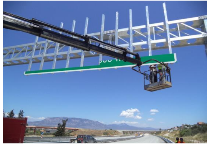
Εγκατάσταση πινακίδων ενημέρωσης
