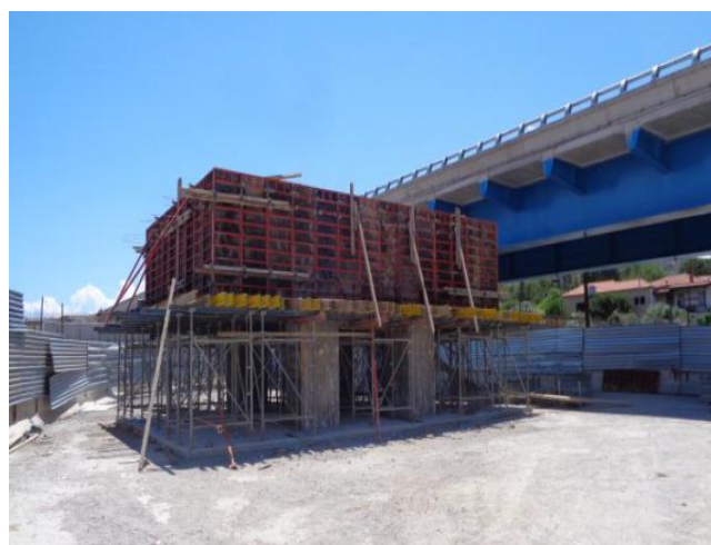
B322 – Κατασκευή Μ3-Μ4
