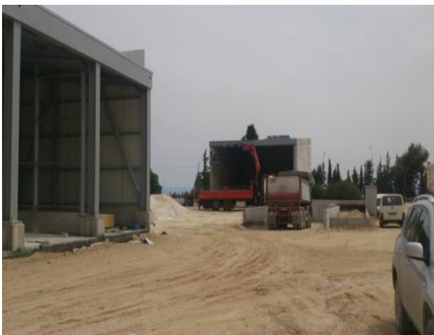
Εγκατάσταση μεταλλικής κατασκευής στην Αποθήκη Αλατος (Υ169) Τεχνική Βάση Κιάτου
