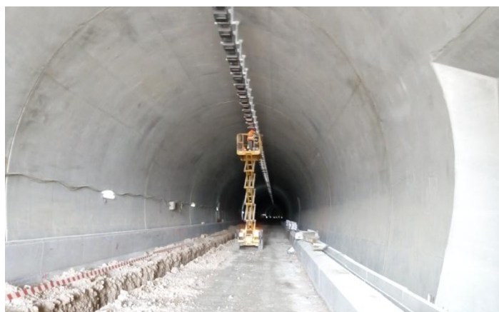
Σήραγγα Πλατάνου, εγκατάσταση ηλεκτρομηχανολογικών υποδομών
