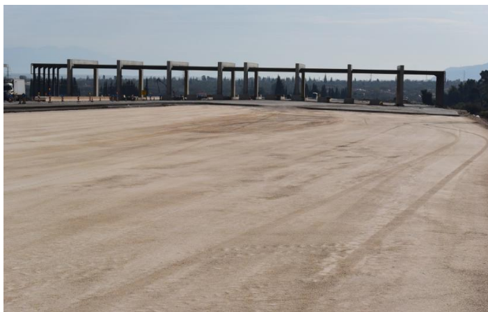
Εργασίες οδόστρωσης στο Σταθμό Διοδίων Νικολαίικαχ. θ. 78+050 έως 78+250
