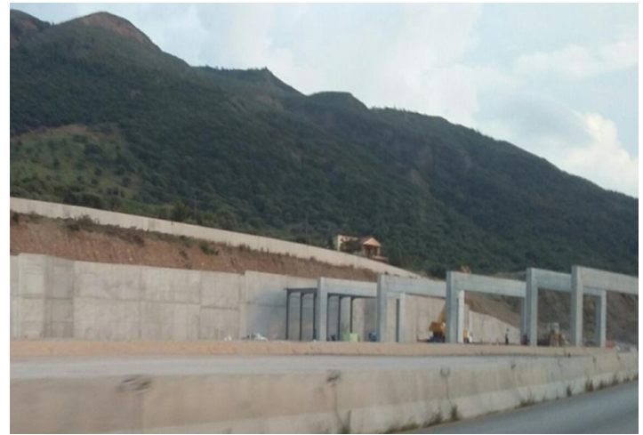
Μετωπικός Σταθμός Διοδίων στο Ριο
