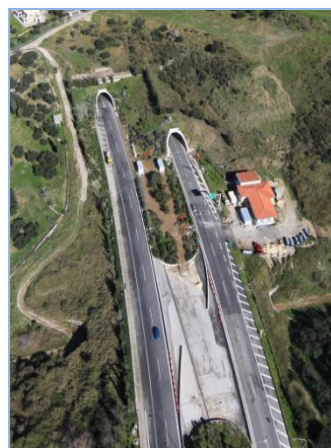
Άποψη της υφιστάμενης κατάστασης της ΕΠΠ
