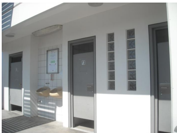
Εργασίες ολοκλήρωσης κατασκευής συγκροτήματος τουαλετών
