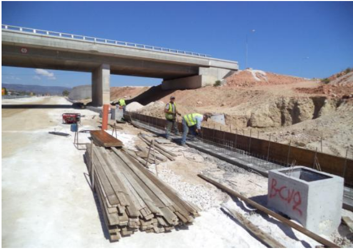
Κατασκευή αποχέυτσης χ.θ. 7+900 έως 9+500
