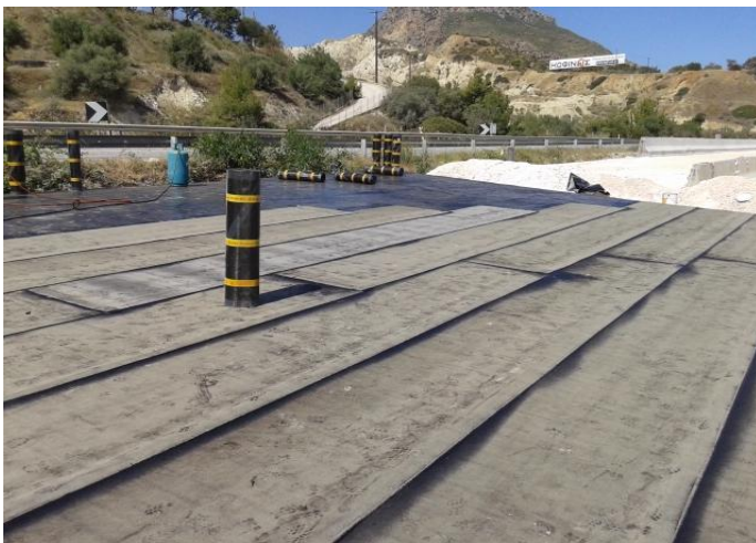
Κάτω διάβαση K221 – Εργασίες στεγανοποίησης
