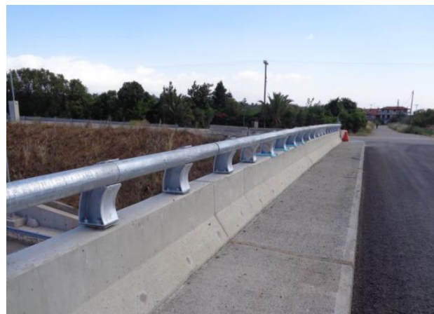
A293 – Εγκατάσταση κυκλιδωμάτων ασφαλείας
