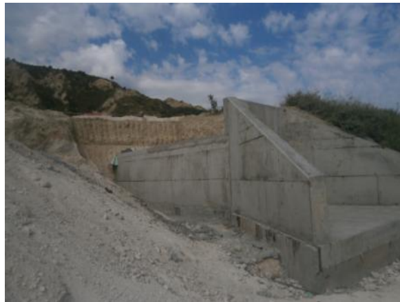
L234 – Ανακατασκευή βορείου τμήματος
