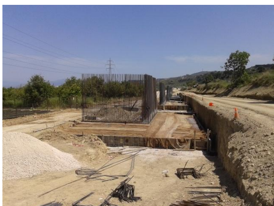
Κατασκευή δομής αντιστήριξης R274
