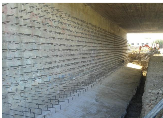
Κατασκευή της υπόγειας διάβασης K305
