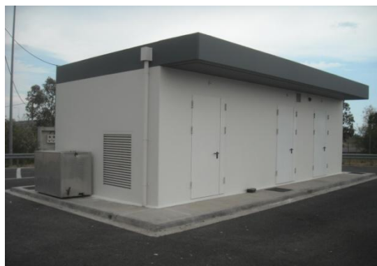
Κτήριο Η/Μ στο σταθμό διοδίων Πάχης
