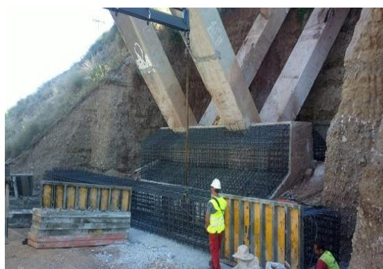
A296 – Ενίσχυση εδράνων και κατασκευή στο M1
