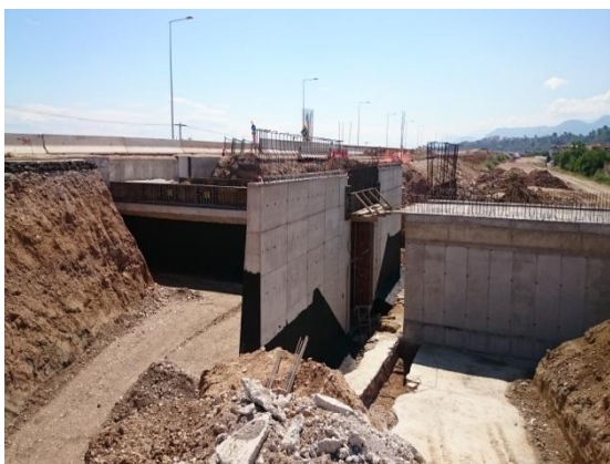
Κατασκευή του τεχνικού K309
