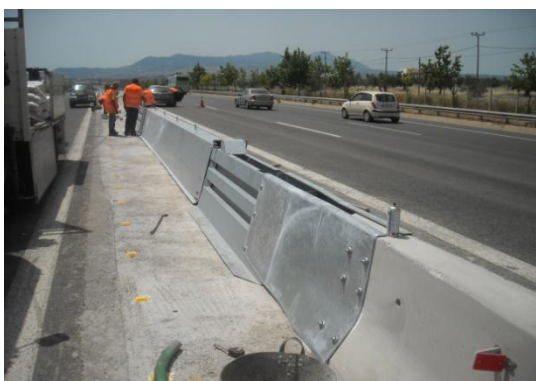
Εργασίες ασφαλείας-τοποθέτηση θύρας στο άνοιγμα έκτακτης ανάγκης χ.θ. 43+100
