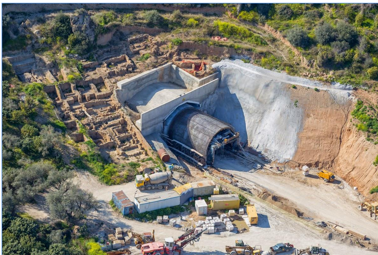
Αεροφωτογραφία Αρχαιολογικού χώρου Θεάς Δήμητρας (σήραγγα T13A)
