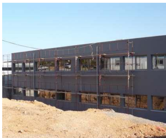
Εργασίες στο ΚΕΣ βόρειο τμήμα
