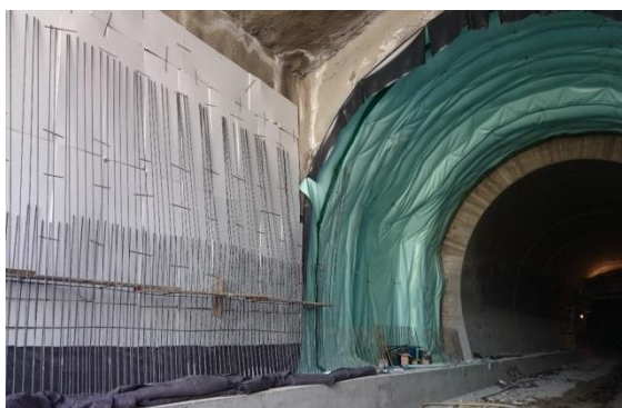
Αδιαβροχοποίηση εισόδου σήραγγας
