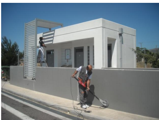
Κτήριο Τουαλετών στο χώρο στάθμευσης Νέας Περάμου
