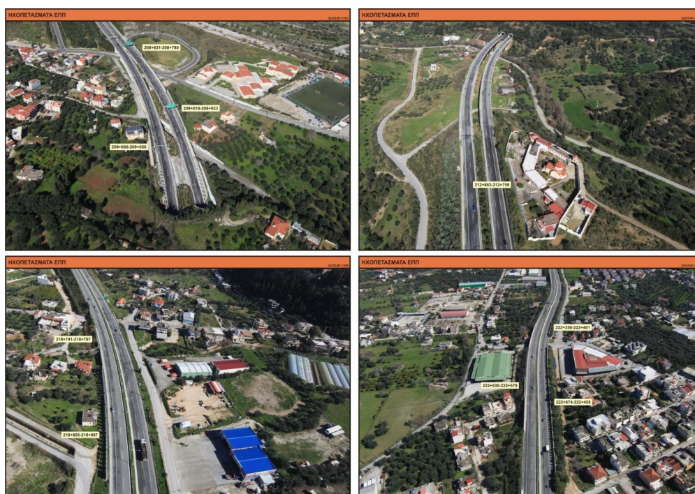
Θέσεις εγκατάστασης αντιθρομβικών πετασμάτων στην ΕΠΠ
