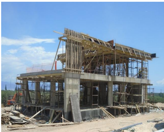
Κατασκευή κτηρίου διοδίων στα Νικολέϊκα
