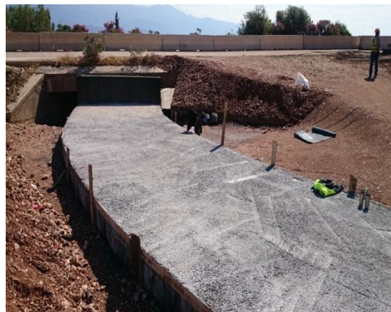
Κατασκευή του τεχνικού L518
