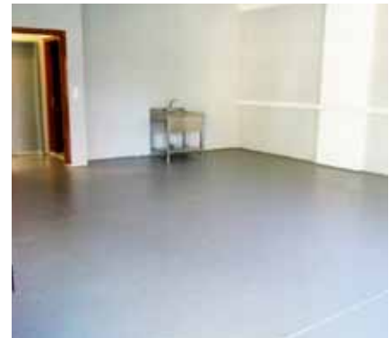
Χώρος εργαστηρίου κτιρίου αποθήκης 25ης ΕΒΑ
