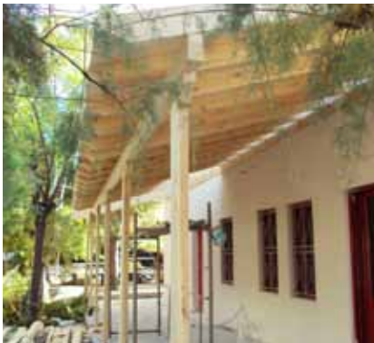
Σκεπή ισογείου κτιρίου αποθήκης 25ης ΕΒΑ
