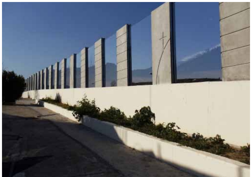
Εγκατάσταση αντιθορυβικών πετασμάτων, στα υφιστάμενα τμήματα του Έργου (Ι. Μονή Ζωοδόχου Πηγής, Ευρεία Παράκαμψη Πάτρας)
