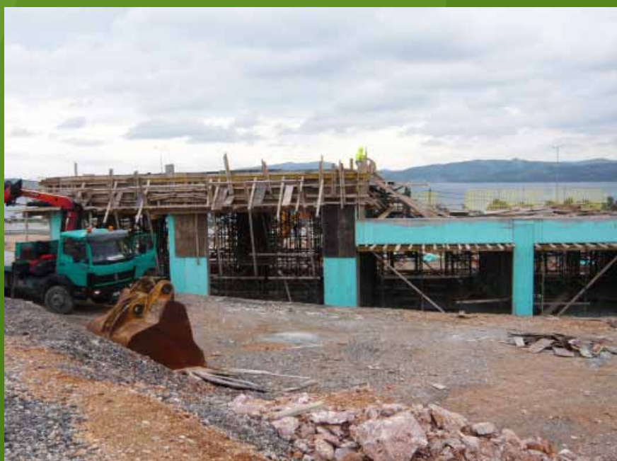
Εργασίες σκυροδέτησης του ΚΕΣ Νέας Περάμου
