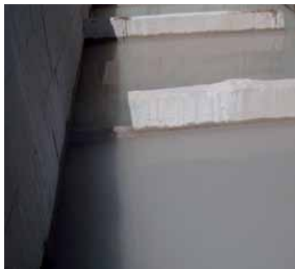
Δεξαμενή καθίζησης στην σήραγγα Παναγοπούλας
