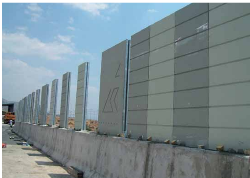
Εγκατάσταση αντιθορυβικών πετασμάτων, στα υφιστάμενα τμήματα του Έργου
