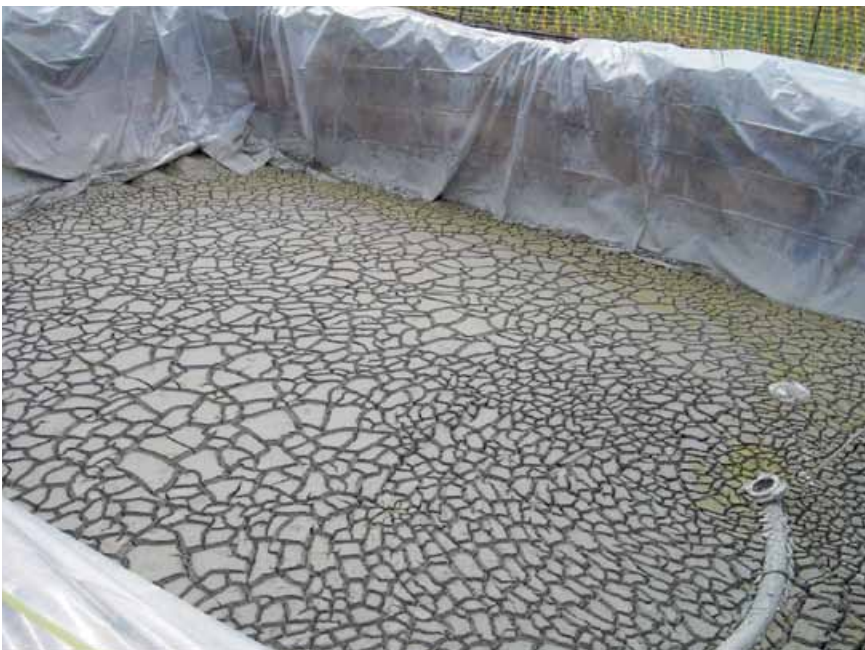
Δεξαμενή επαναχρησιμοποίησης μπετονίτη στον π. Αλφειό
