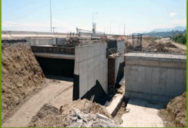
Κατασκευή τεχνικού Κ309
