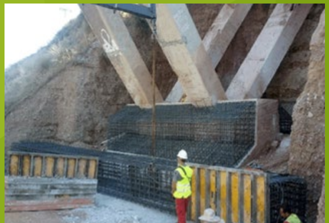
296 Ενίσχυση πέδιλου και κατασκευή τοιχίου M1
