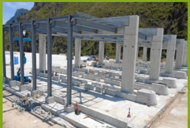
Κατασκευή Σταθμού διοδίων στα Νικολέϊκα
