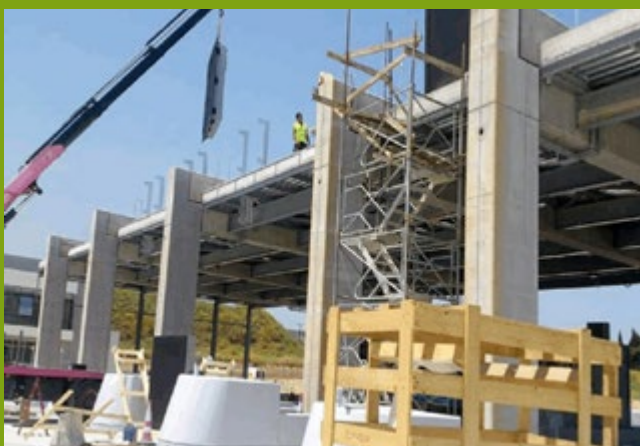
Εργασίες στο σύστημα διοδίων από την IBI
