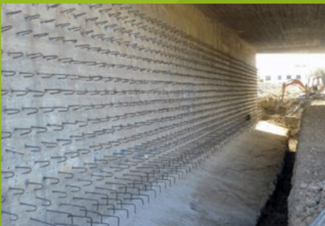
Κατασκευή κάτω διάβασης K305
