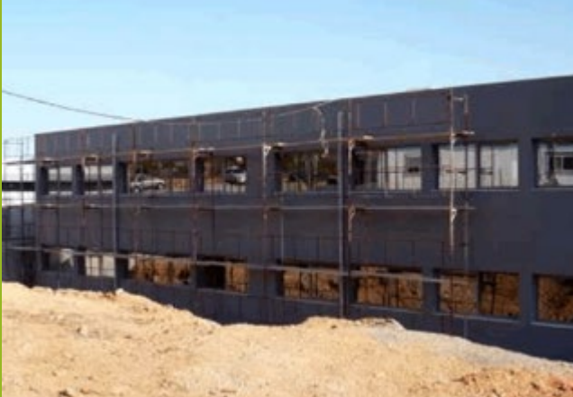
Εργασίες βαψίματος στο Βόρειο Τμήμα του ΚΕΣ
