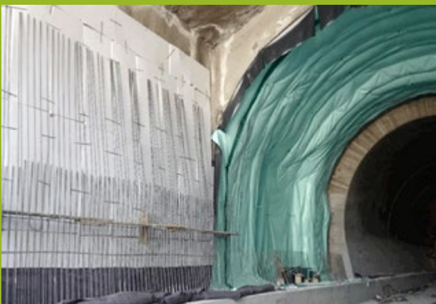
Τελικό στάδιο επικάλυψης - αδιαβροχοποίησης ορύγματος
