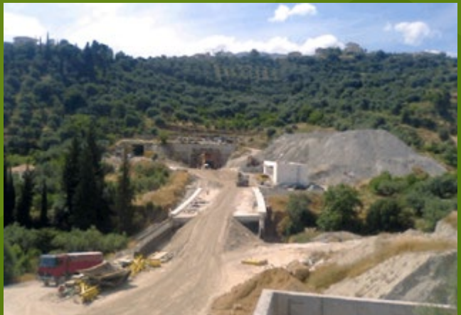
Εργασίες στη Γέφυρα Κρύου
