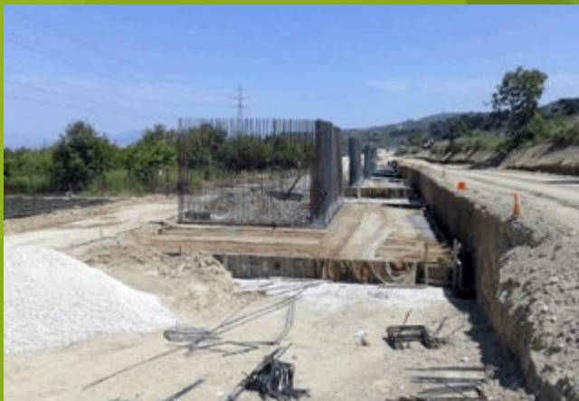
Κατασκευή τοίχου αντιστήριξης R274
