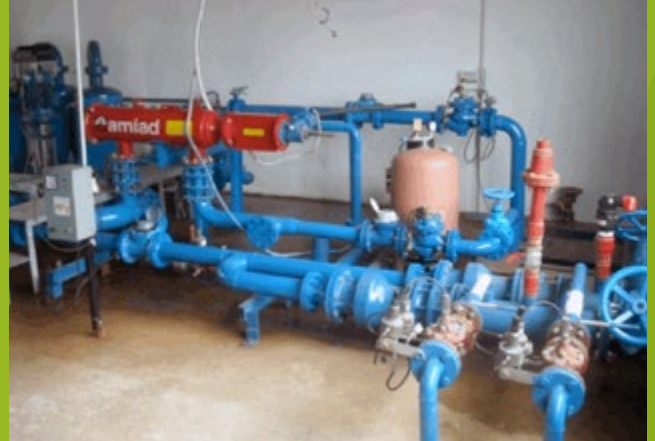
Η/Μ εργασίες στην γεώτρηση P3
