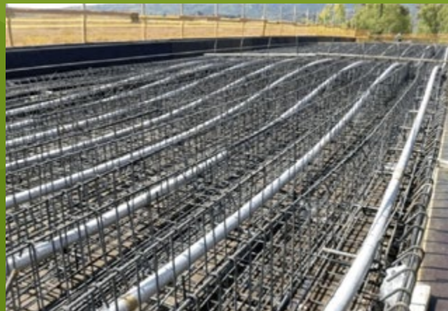
Ανω διάβαση A207 εφαρμογή ενίσχυσης στο κατάστρωμα
