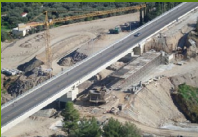
Κατασκευή του Β269
