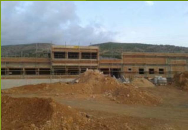
Εργασίες στο κτίριο ελέγχου (μονάδες 2 & 3)
