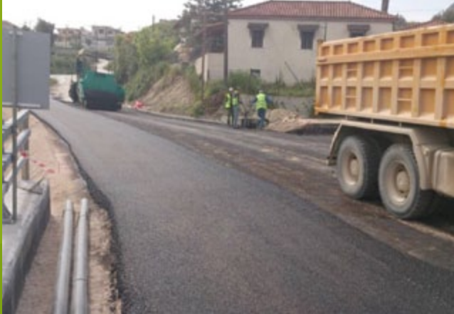
Εργασίες ασφαλτόστρωσης, Α103
