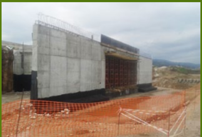
Κατασκευή κάτω διάβασης Κ311 στη χ.θ. 92+297.49
