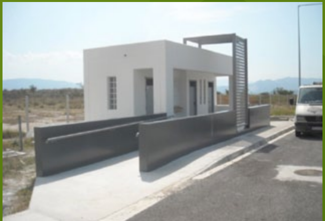
Χώρος στάθμευσης Καλαμάκι προς Ελευσίνα: εργασίες αποπεράτωσης
