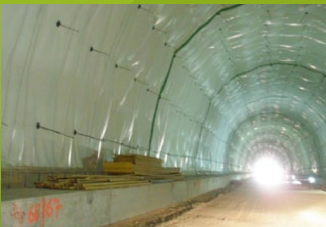
Εργασίες υδατοπροστασίας και τελικής κάλυψης στη σήραγγα Μαύρα Λιθάρια
