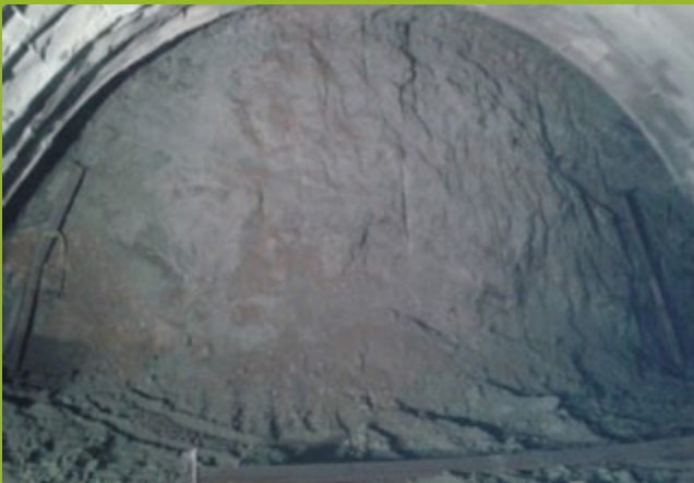
Α' φάση εκσκαφής σήραγγας
