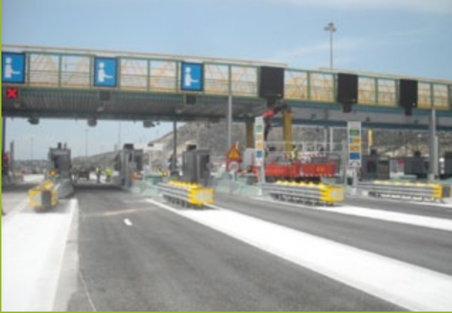
Σταθμός διοδίων Ισθμού
