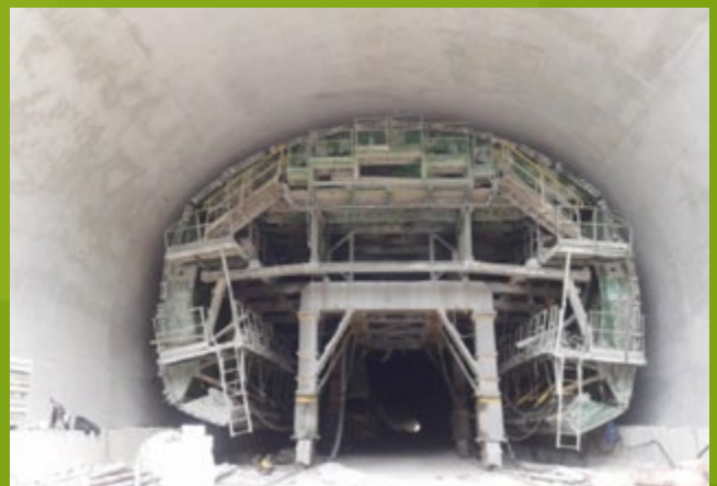
Cut & Cover T007 Δυτικό: τμήμα 2
