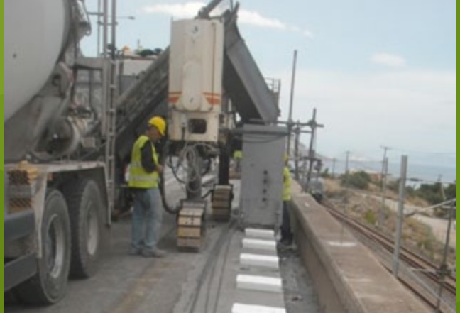
Κατασκευή τσιμεντένιων στοιχείων
