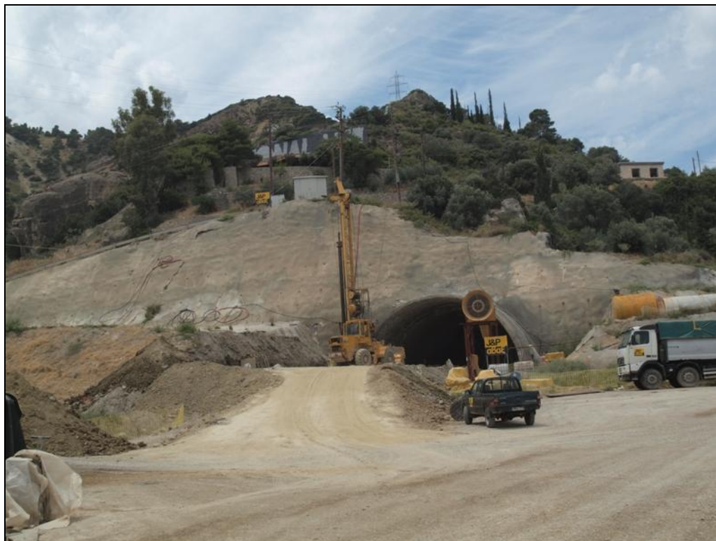
Κατασκευή στην ανατολική είσοδο της σήραγγας T11
