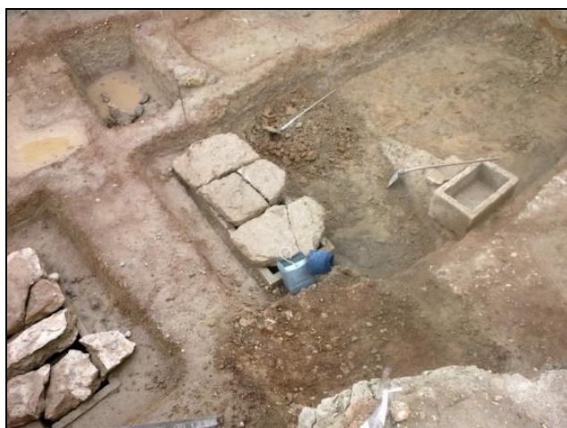
ΣΙΚΥΩΝΑ (ΜΟΥΛΚΙ), Χ.Θ. 17+020, τμ. ΚΟ-ΠΑ Ανασκαφή σε αρχιτεκτονικά κατάλοιπα
