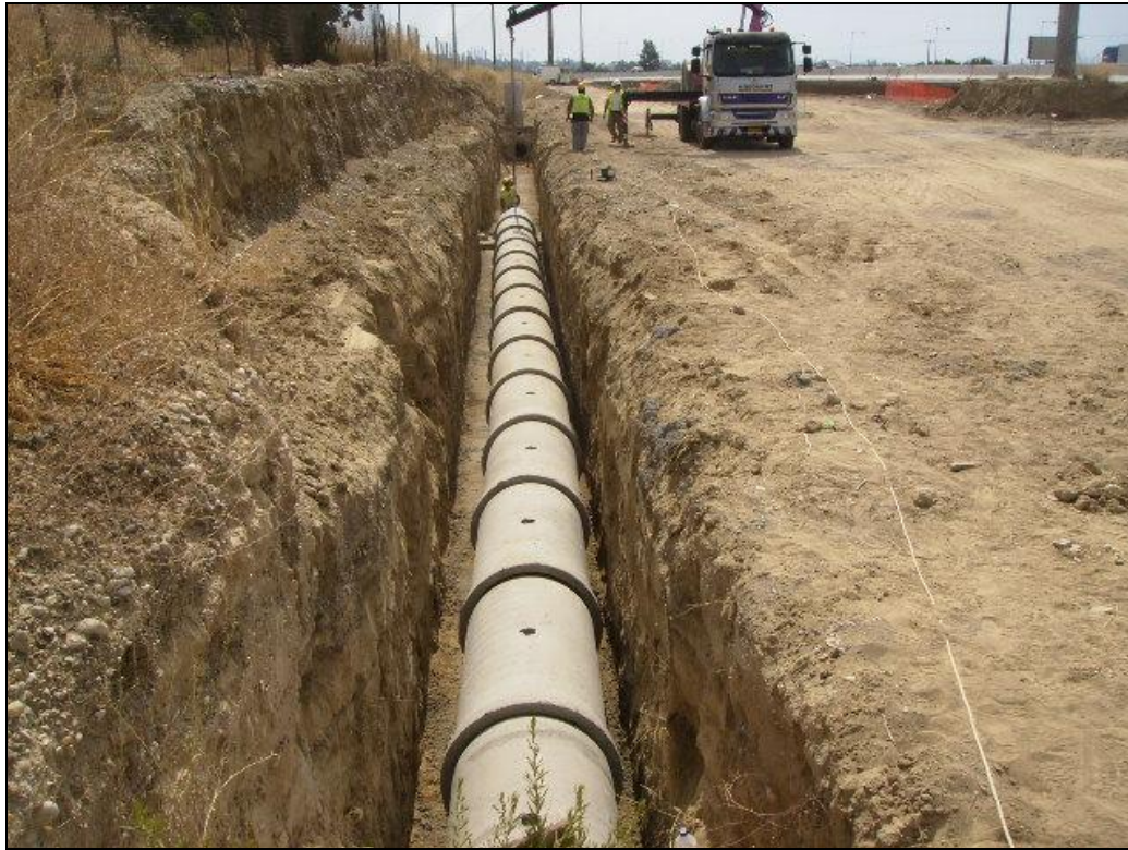
Σταθμός Διοδίων Ισθμού: τοποθέτηση νέου δικτύου ομβρίων υδάτων
