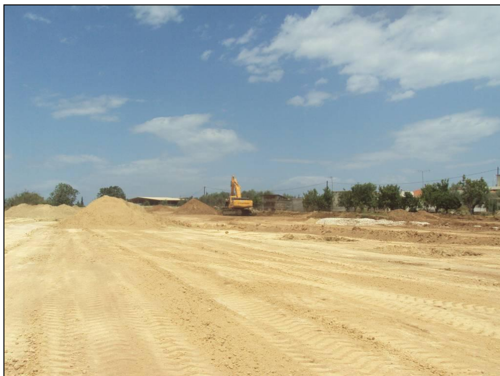
Εκσκαφική δραστηριότητα στο νέο Σταθμό Διοδίων, Ζευγολατιό
