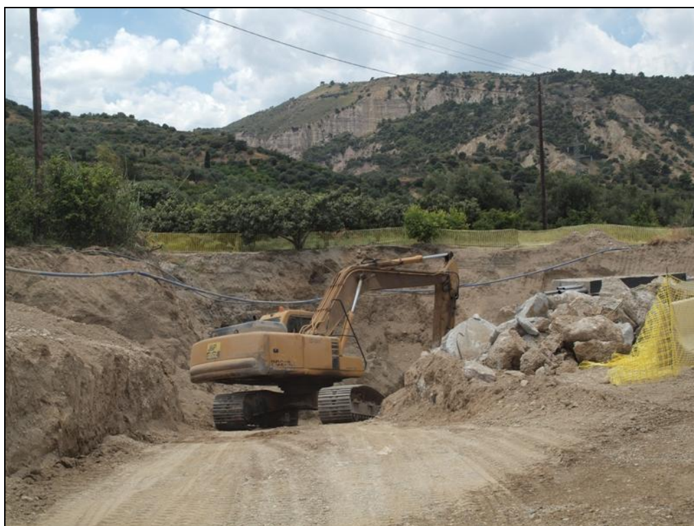
Εκσκαφή για την κατασκευή της γέφυρας Ροζένα (Β245)
