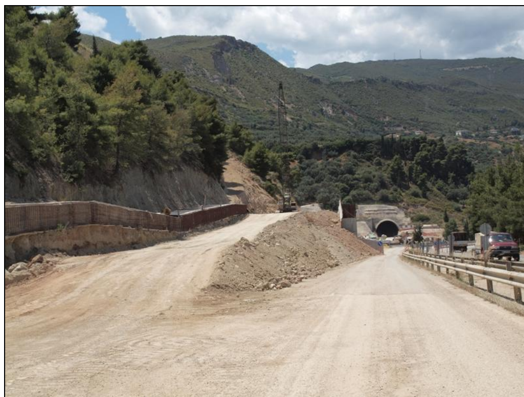
Χωματουργικές εργασίες του Lane Cover C007 στον Πλάτανο
