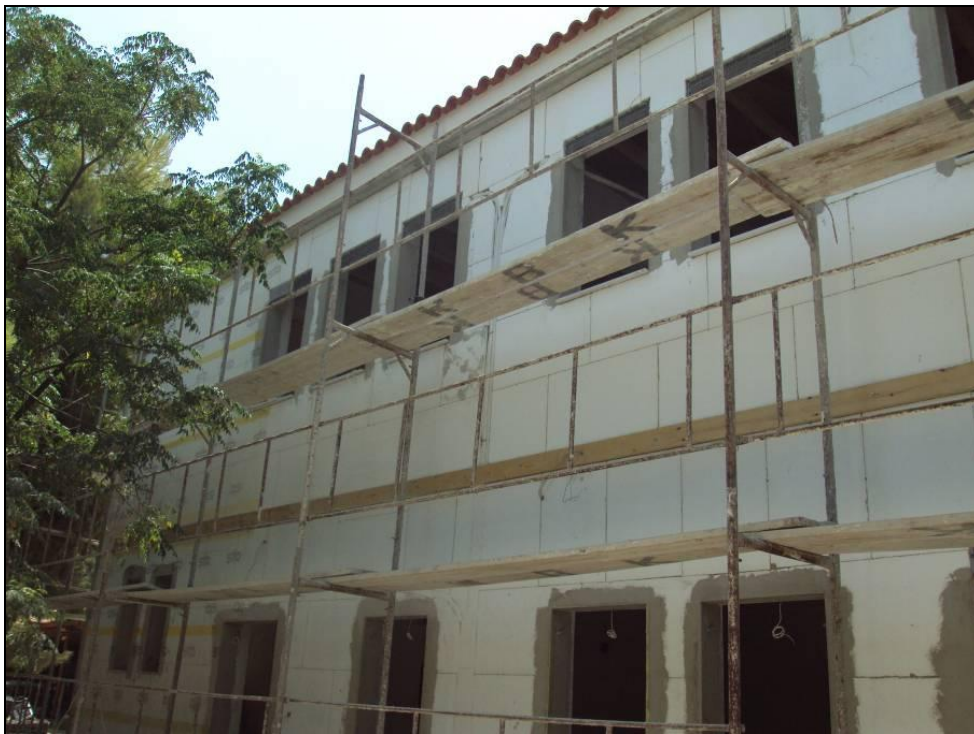
Εξωτερική μόνωση – 25 η ΕΒΑ
