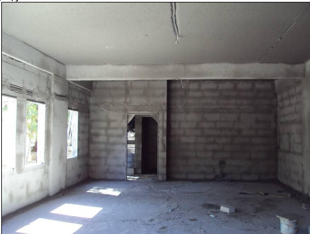
Σοφάτισμα τοιχοποιίας 25 ΕΒΑ
