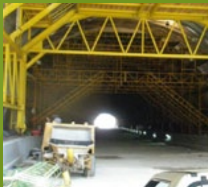
Σήραγγα 13B - Εργασίες τελικής επένδυσης
