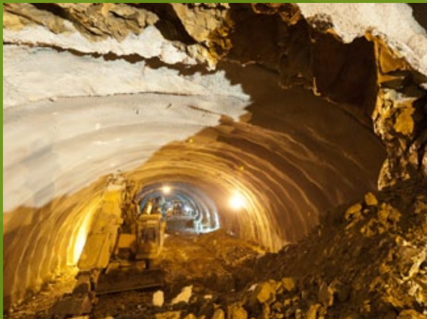
Σήραγγα 26 - ολοκλήρωση εκσκαφής
