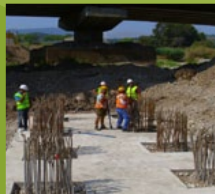
Εργασίες κατασκευής της γέφυρας π. Μεγανίτη
