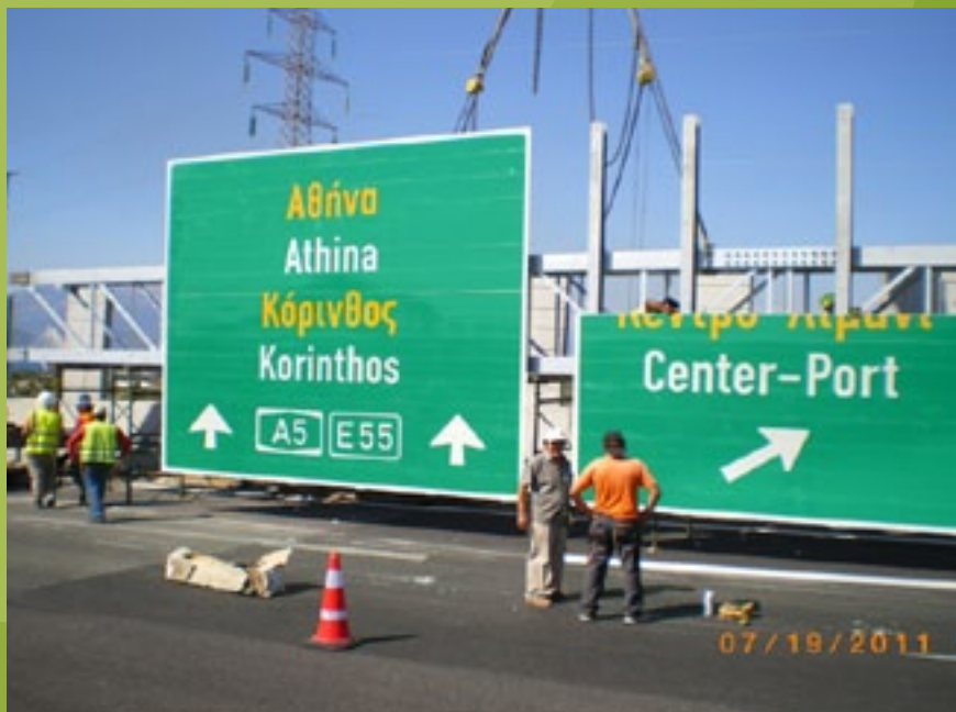
Τοποθέτηση οριζόντιας σήμανσης
