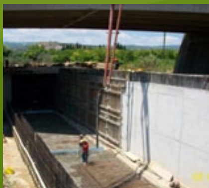
Γέφυρα Β131 (Χ.Θ. 19+320) - Κατασκευή 2ης φάσης του τεχνικού
