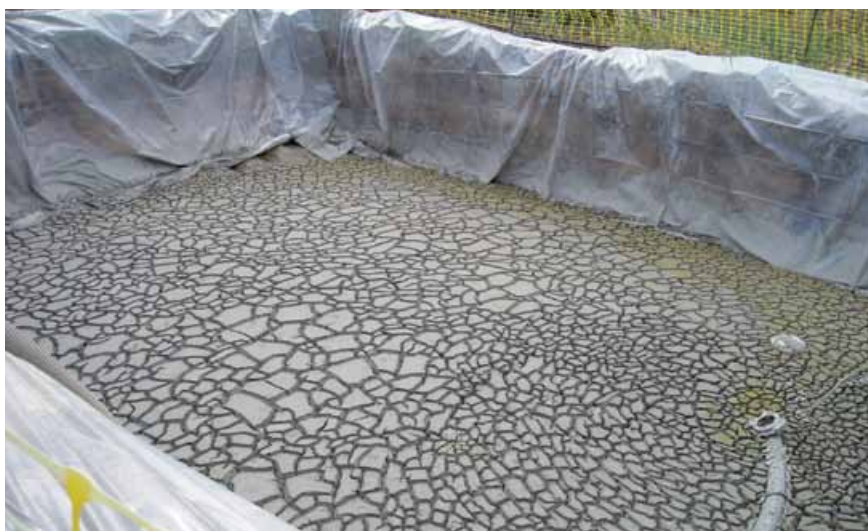
Δεξαμενή επαναχρησιμοποίησης μπετονίτη στον π. Αλφειό
