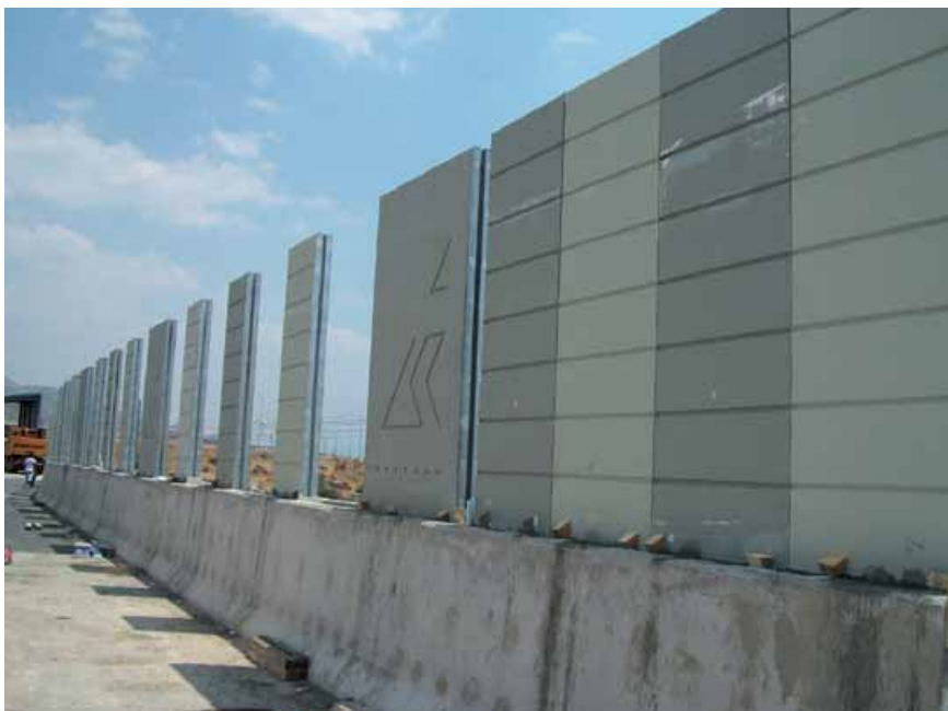
Εγκατάσταση αντιθορυβικών πετασμάτων, στα υφιστάμενα τμήματα του Έργου
