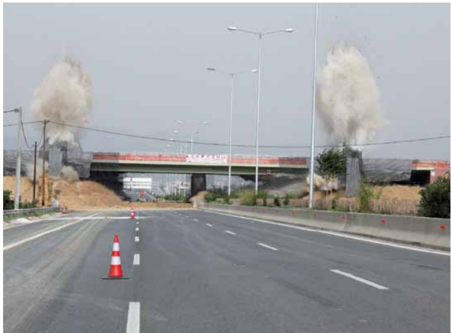
Έλεγχος δονήσεων κατά την κατεδάφιση της γέφυρας Πάχης
